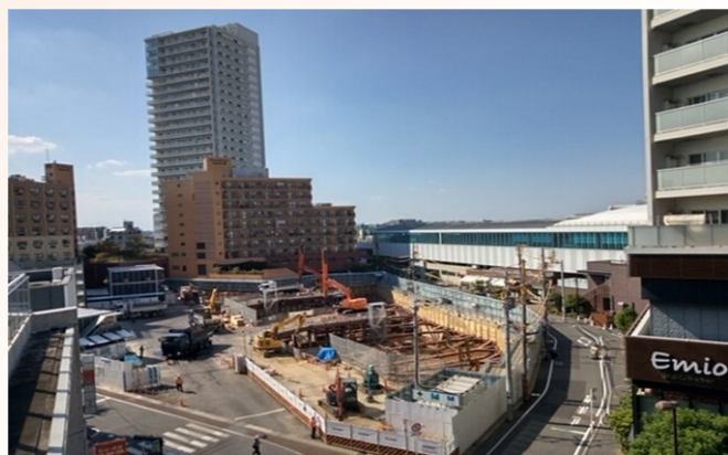
▲建設工事が着々と進む駅前再開発ビル工事 完成まで期間を どう対応するのか
